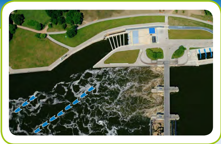
Bild 5: Position der Aalreusen neben der Kraftwerksausströmung.
