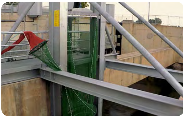
Bild 3: Stahlkonstruktion unterhalb der landseitigen Turbine mit Fanghamen
