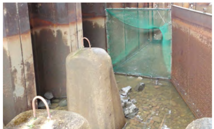
Bild 1: Fangeinrichtung mit 10 mm Netzreuse
